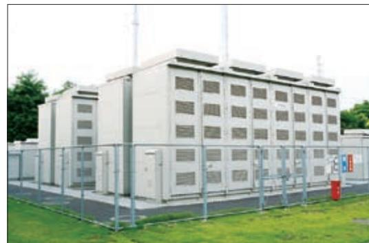
工場では「電力貯蔵用NAS電池システム」を導入し、電力需要の少ない夜間に貯蔵した電力を昼間に利用して、使用電力のピークを抑制
