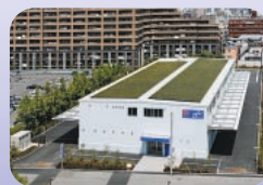
屋上緑化したエコ事業所
