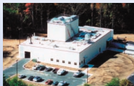
Fuji Foods Inc. バーリントン工場
