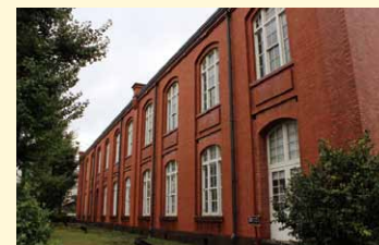
現在は「近世史料館」として公開されている、威風堂々たる赤レンガ造の工場建物部分
