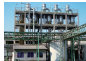
酵母培養液の濃縮設備
