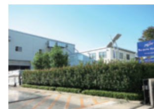
「リサイクル・プラザJB」外観
