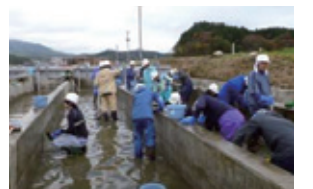
サケの養殖場の復旧作業
