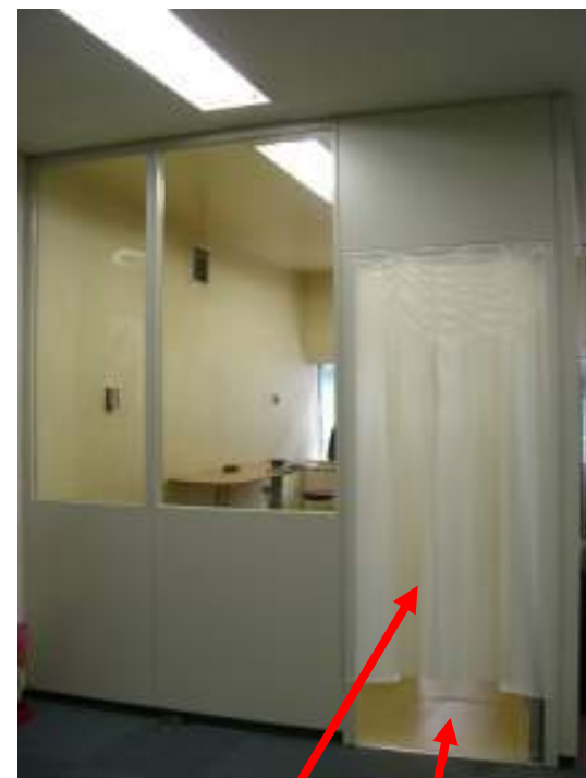
ビニールカーテン
