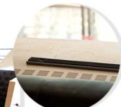
約20の席を有する喫煙エリア。エアカーテンは、ソファの背もたれの背後に設置されているため、フロアのイメージを損なうこともない。
